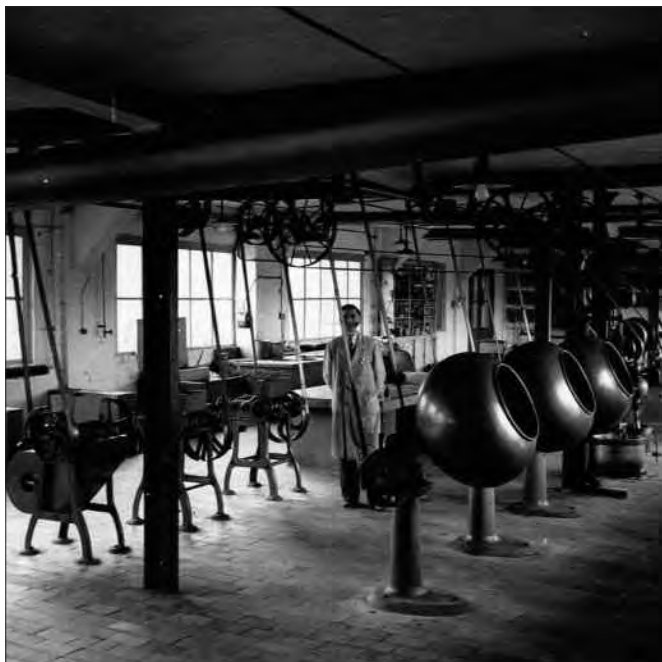
Productiehal, machinepark. (AJvdG). Opvallend zijn de drageertrommels. In deze toestellen worden laagjes suikerglazuur aangebracht op chocolade, hazelnoten, enz. of laagjes chocolade op noten en gedroogd fruit.
