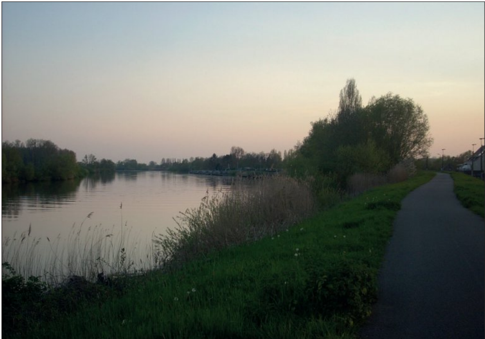
Afb. 3: De Schelde en de dijk van net voorbij Het Schipken in de richting van de Kleine Dijk en Appels-Veer. De huidige Sigmadijk is dubbel zo breed als de vorige. Vanaf hier lijkt de dijk zich wat te verwijderen van de oever. De begroeide strook binnendijks voorland loopt breder uit in de richting van Costa Zela.
