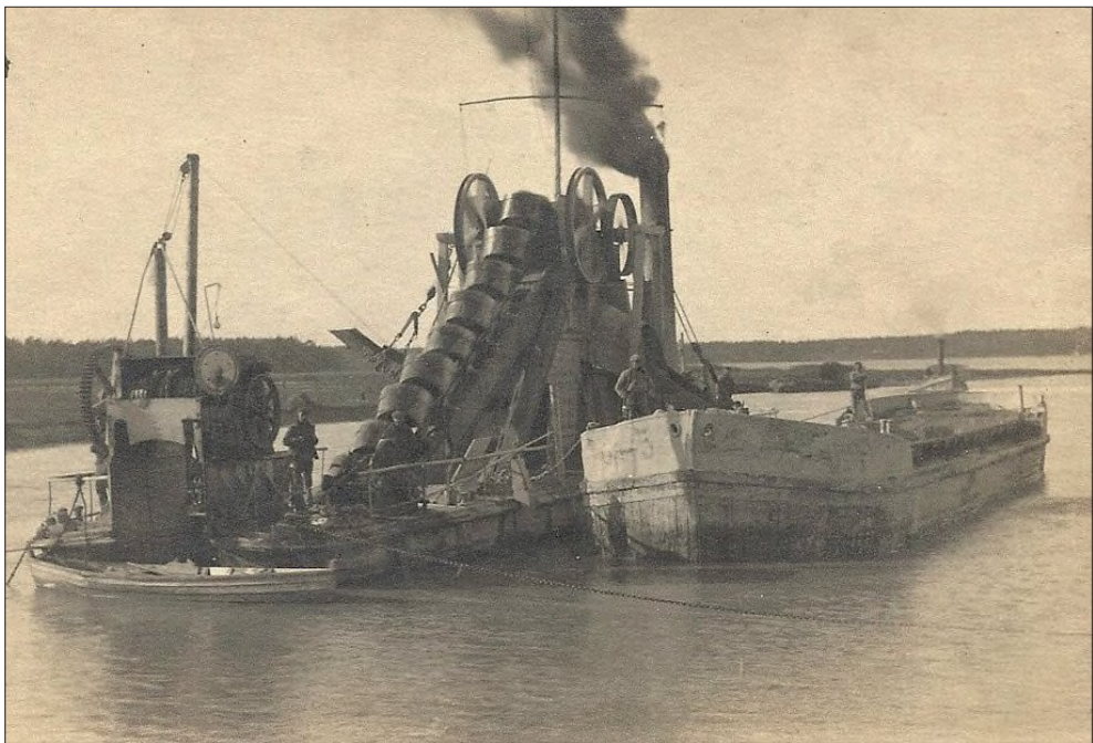
Afb. 1: Een emmerbaggerschip rond 1930 aan het werk op de Westerschelde nabij Saeftinghe. Bemerkt de kuipen aan de continuketting, de draaiende vliegwielen en de grote stortgleuf naar de naastgelegen platbodemschuit (duwbak).
